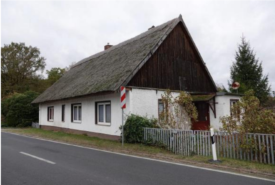
Wohnhaus – Ansicht von Südosten
