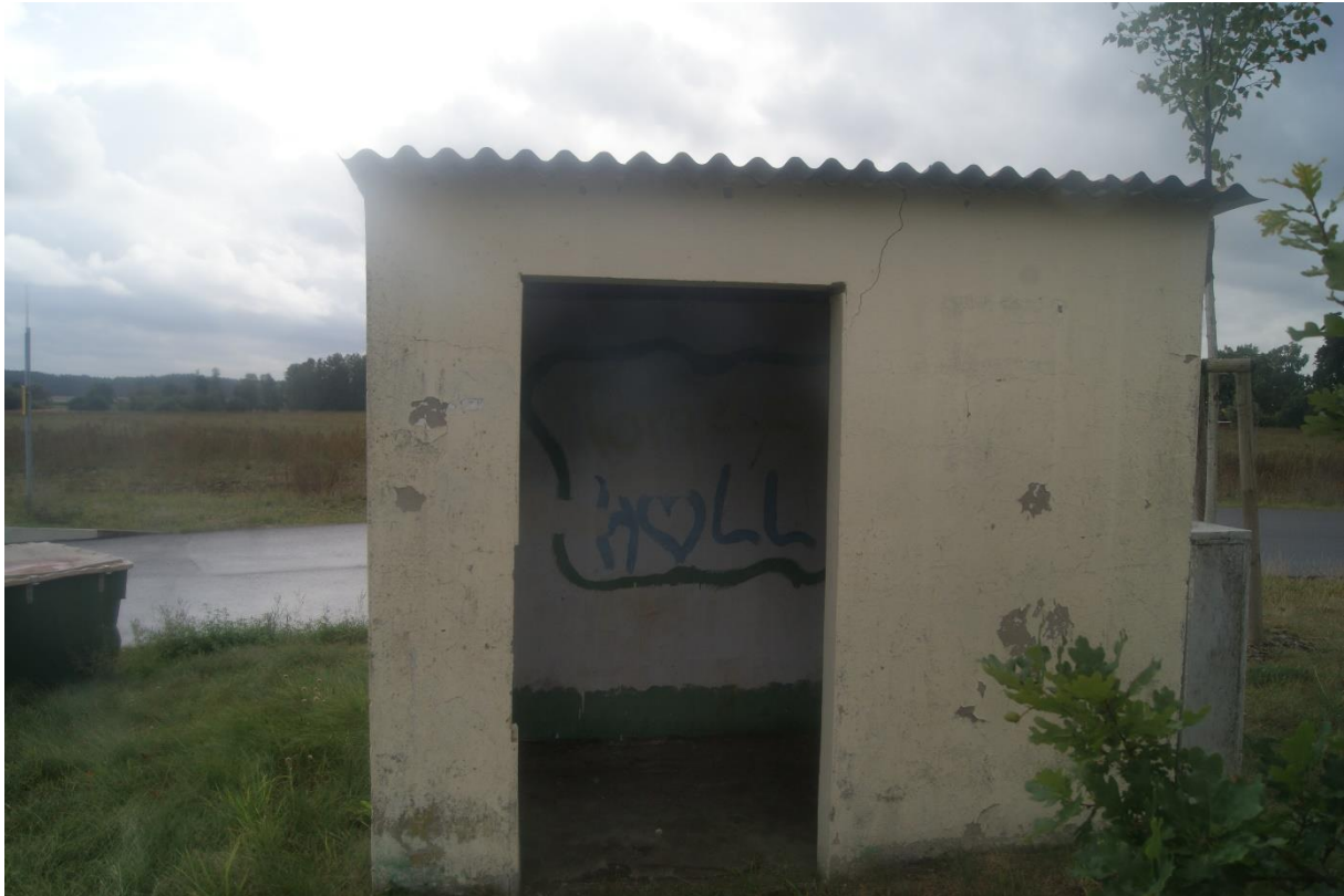
Bild 09: Unterstand im Bereich der Buswendeschleife
