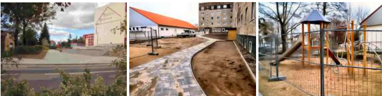
2. BA Bahnhofstraße kurz vor Fertigstellung
