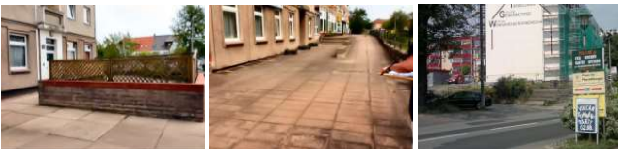
2. BA Bahnhofstraße vor der Maßnahme
