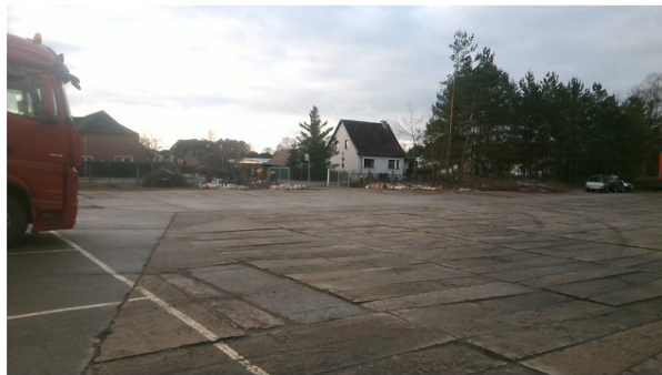
Abb.5. Versiegelte Fläche nach Nord- Ost aufgenommen.
